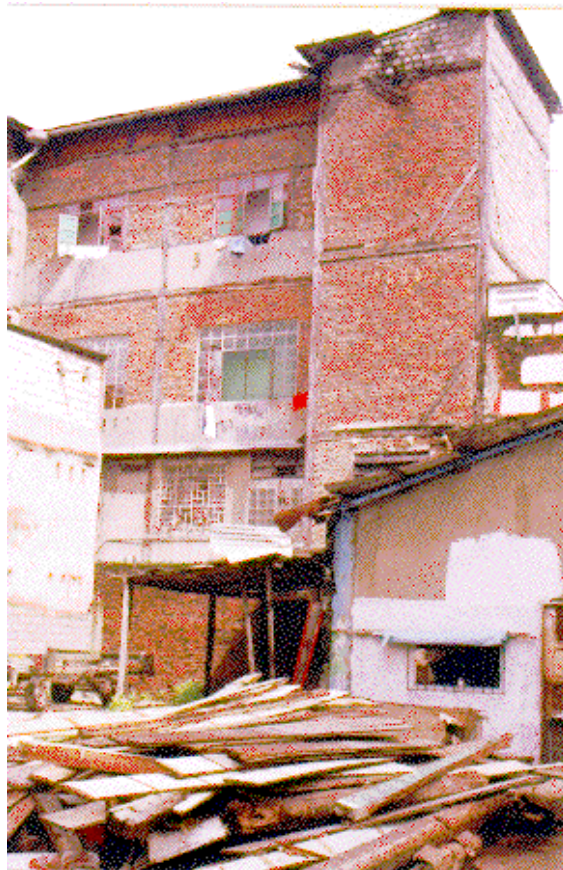
Este edificio construido con estructura de madera y paredes de ladrillo (construcción mixta), es uno de los tipos de estructuras que puede sufrir severos daños durante un terremoto de intensidad M.M.=VIII.
