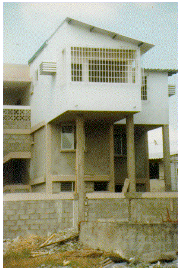
Un tipo de estructura con alto riesgo sísmico son algunos de los condominios del BEV en Sauces IX, en los que se han introducido ampliaciones sin diseño y supervisión técnica. (Tomado de los
